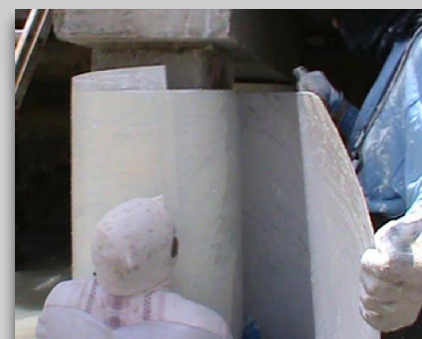
Corte lámina de PileMedic™ al tamaño deseado
