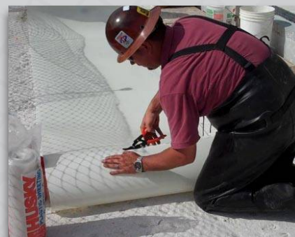
Corte lámina de PileMedic™ al tamaño deseado
