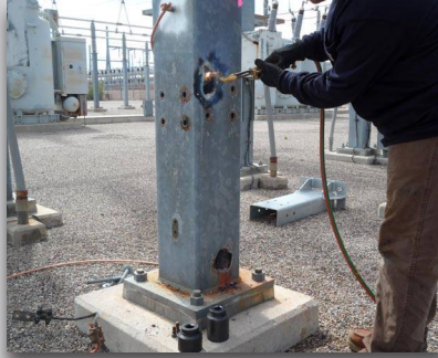
Corte un agujero aproximadamente a 30-pulg de altura sobre el suelo
